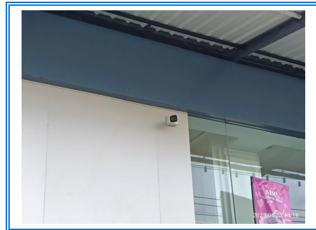
รูปที่ 3-48 ติดตั้งระบบกล้องวงจรปิด CCTV ภายนอกอาคาร
