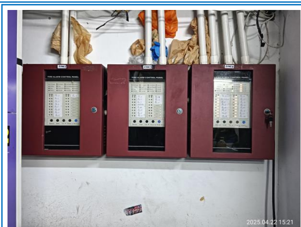
รูปที่ 3-38 อุปกรณ์แจ้งเหตุเตือนภัยและระบบควบคุมการแจ้งเหตุเตือนภัย
