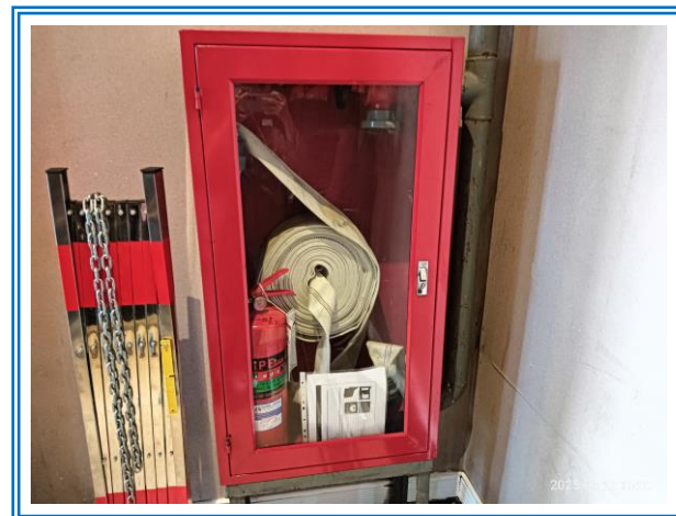
รูปที่ 3-39 ตู้เก็บสายฉีดน้ำดับเพลิงและถังดับเพลิง
